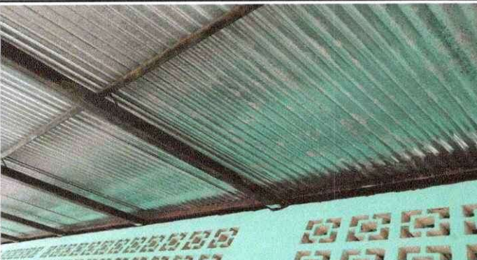
Foto 3: Mantenimiento a estructura de costaneras (lijado, Cepillado, cambio de tubo y aplicación de pintura.)
