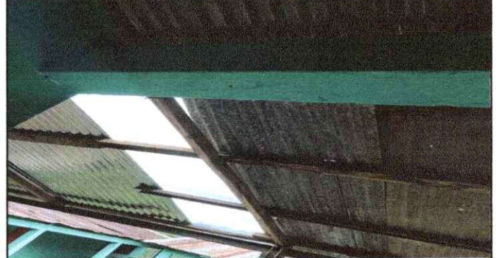
Foto 4: Mantenimiento de viga de concreto.
