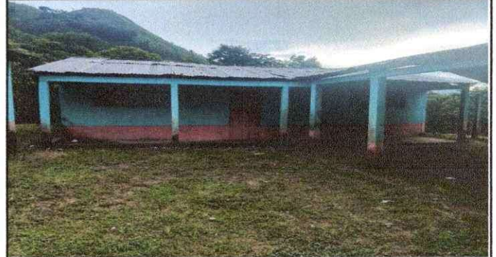
Foto 2: cambio de techo y sustitución de piso de aulas del módulo II
