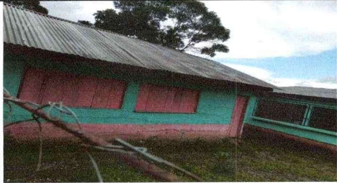
Foto1: Sustitución de lámina normal por lámina troquelada calibre 26
